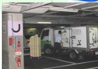
荷捌き駐車場
